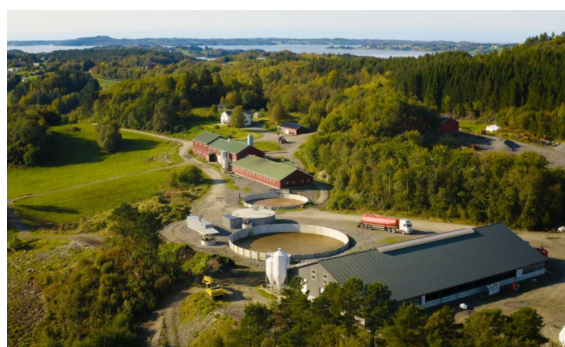
Figur 17: Oversiktsbilde av biogassanlegget på Hoemsnes.
