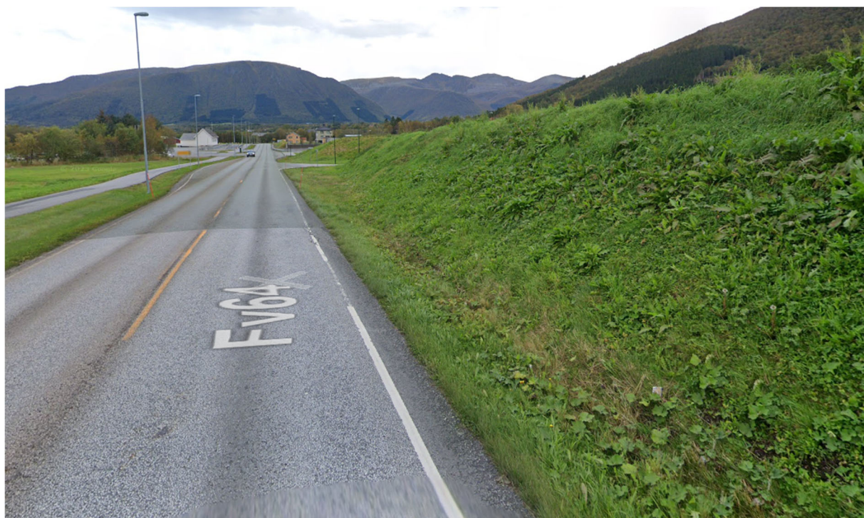
Utklipp 5.15.2: Tiltak langs fylkesvegen i forbindelse med utbyggingen av Lauvåsenområdet. Støyvoll til høyre på bilde, kilde google.no/maps
