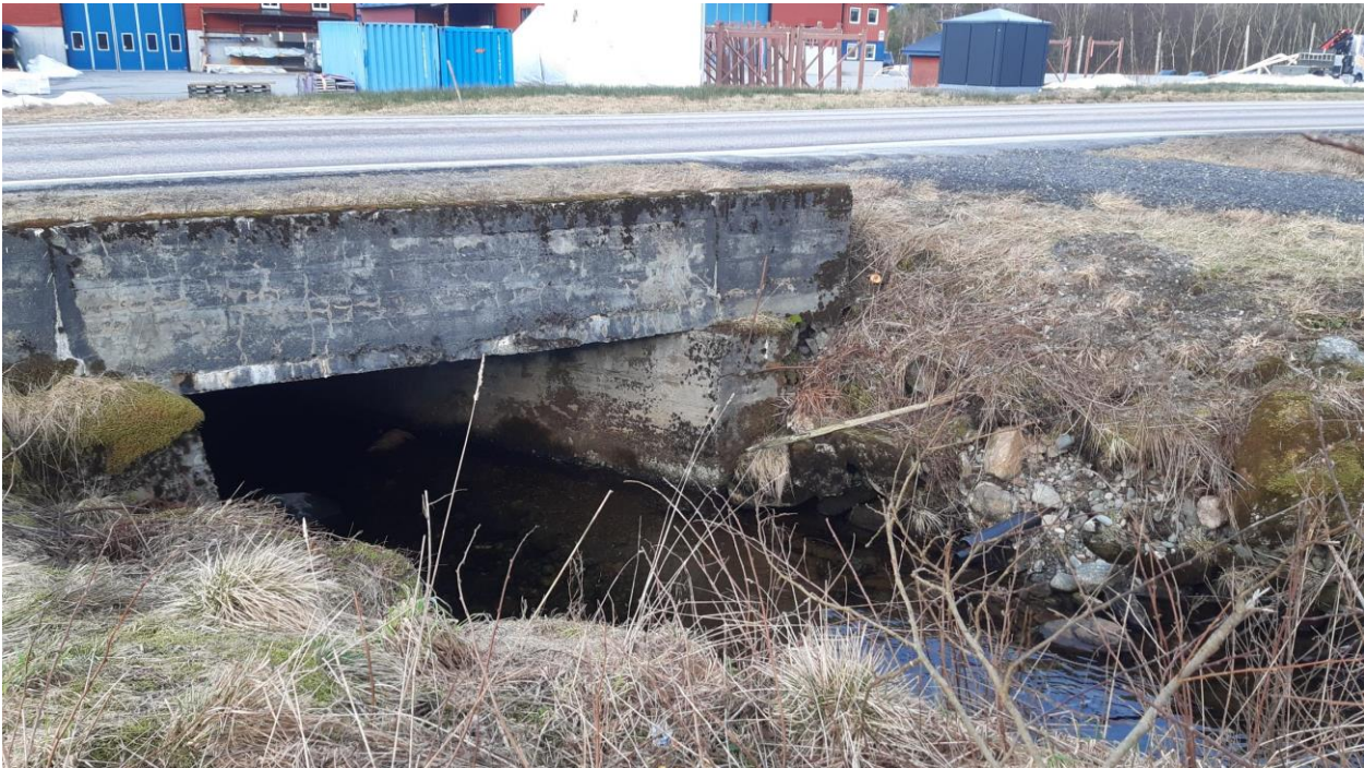
Figur 6: Eksisterende bru under fylkesvei 64 (oppstrøms side). Kilde: JaTre AS, 29.01.2025.
