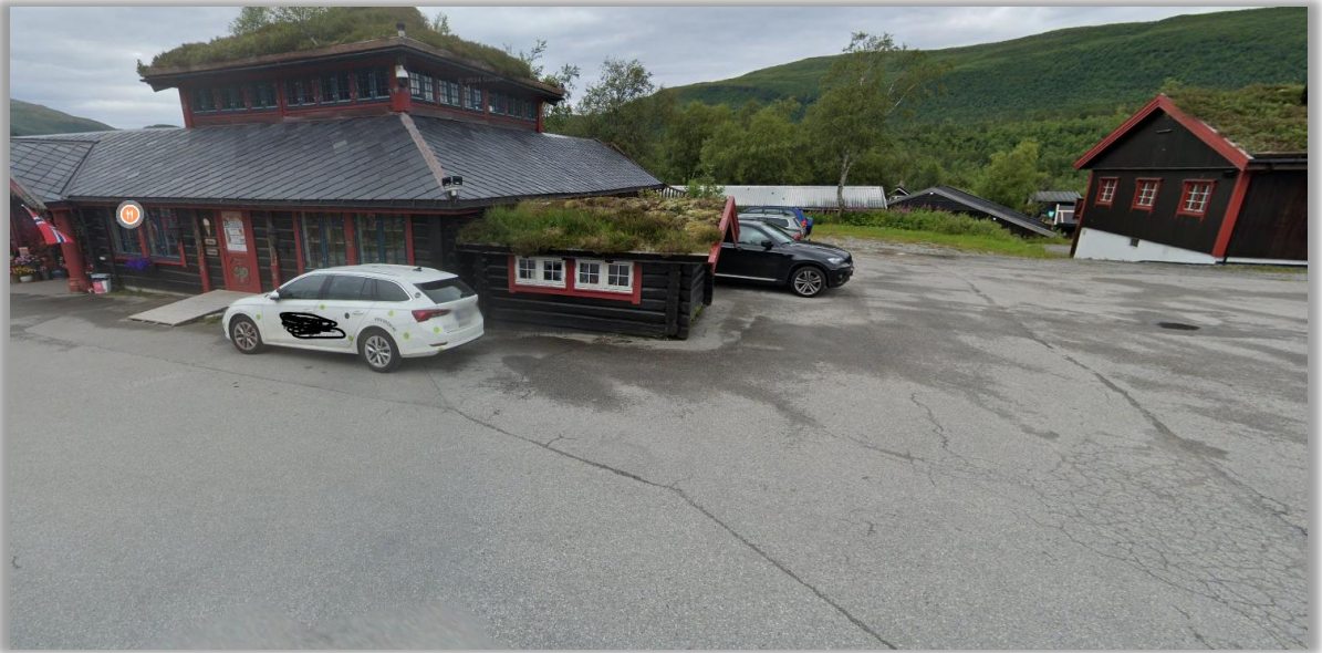
Utklipp 6.5.3 Område ved Skarstua hvor det skal merkes for HC parkering, nærme hovedinngang og nærme inngang med etablert rampe, kilde google.no/maps
