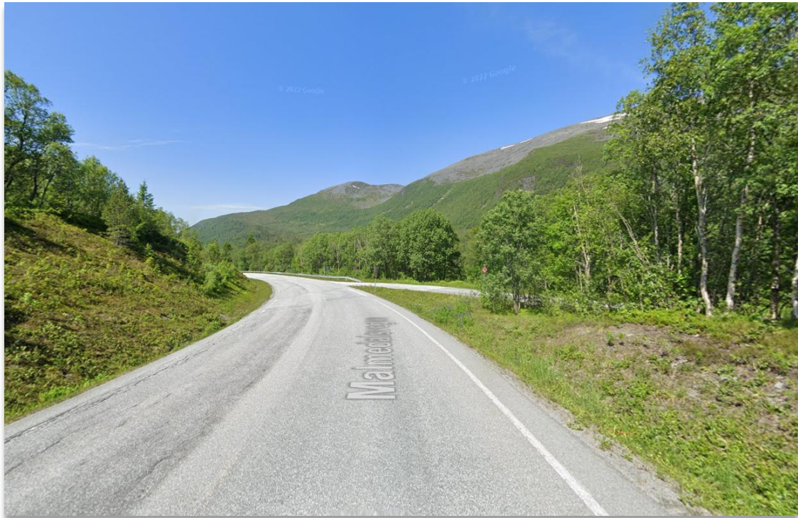
Utklipp 5.9.4: Bilde tatt i kjøreretning mot Malmedalen, den nordligste tilknytningen kommer inn fra høyre, kilde google.no/maps
