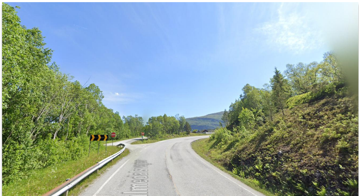
Utklipp 5.9.3: Innkjøring forbudt ved den nordligste tilknytningen, bilde tatt i kjøreretning mot Molde, kilde google.no/maps .
