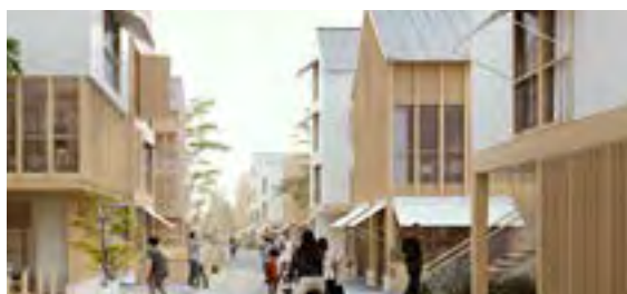
Ubehandlet trekledning med bruk av treverk med høyt malminnhold
