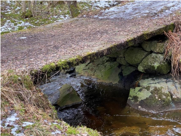
Figur 4 Eksempel på elvekrysning med betongdekke.
