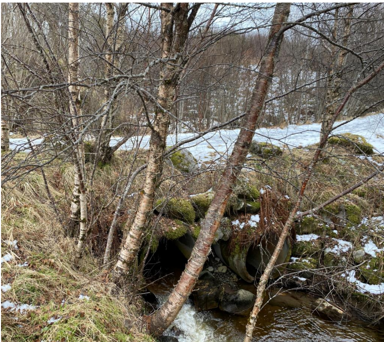
Figur 5 Traktorveikrysning med betongrør midt i modellstrekningen.
