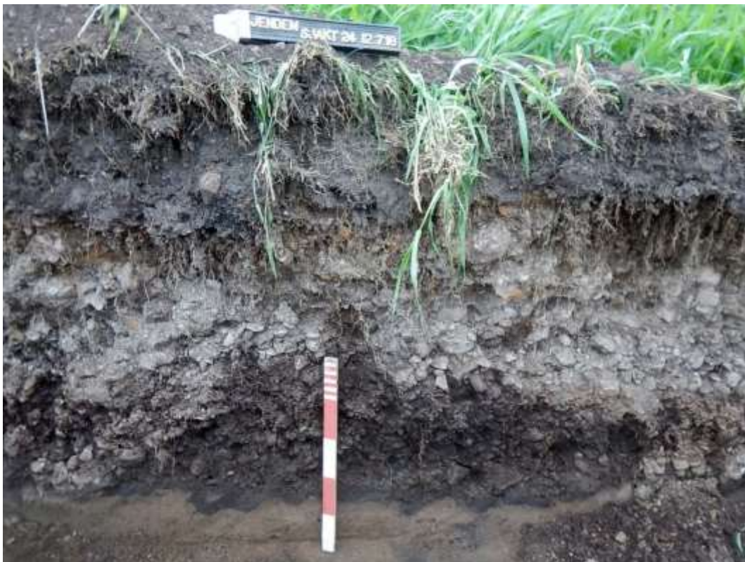
Figur 23: Sjakt 24, profil. Sett Mot SV.
